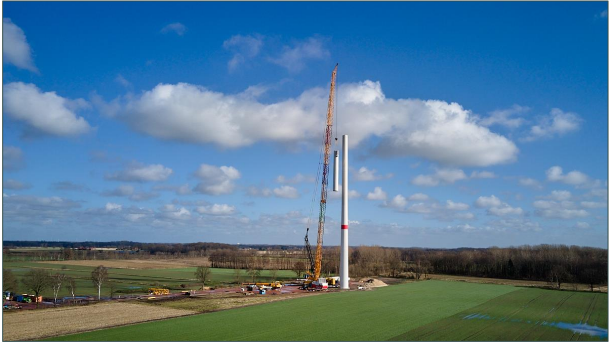
Abbildung 4 - Errichtung des Turms der WEA 07 im Windpark Bakum, Quelle: Alterric Erneuerbare Energien GmbH
