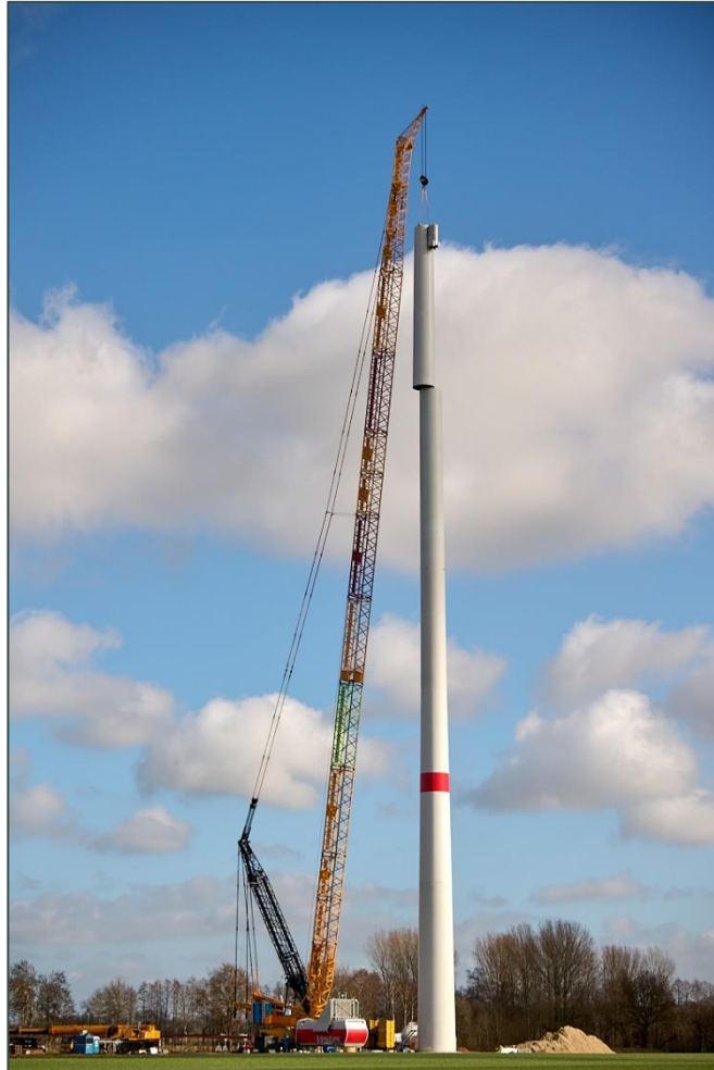
Abbildung 1 - Errichtung des Turms der WEA 7 im Windpark Bakum Quelle: Alterric Erneuerbare Energien GmbH
