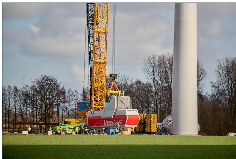
Abbildung 3 – Errichtung der WEA 7 im Windpark Bakum Quelle: Alterric Erneuerbare Energien GmbH
